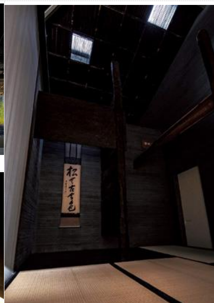
水没する茶室「盤陀庵」。天井には解体した古民家の煤竹、床柱にはバリの古材、茶室内部には越前和紙の壁が用いられている
