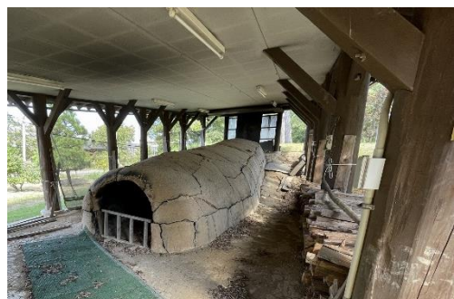
珠洲復元古窯、ひび割れている
